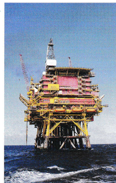
Plataforma para la extracción de petróleo.
